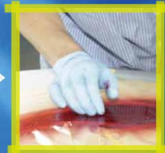
4. 塗料が生乾き状態の時に、爪先でなぞり丹念に細かい波形の模様を付けていく
