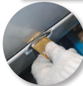
硬い部位のため、しっかりと引き 出せる3つ穴のプレートを用意し、凹 みの形に合うようにプレ ートの先端部を加工する
