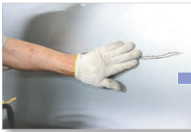
損傷箇所を触手で確認する
