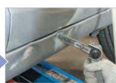
まず車両前方側の凹みから修復する。 P80のペーパーで凹みの深い箇所は ベルトサンダー、全体はディスクサン ダーを用いて塗膜をはく離する
