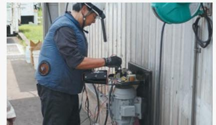
制御盤を外して絶縁抵抗値を測定
