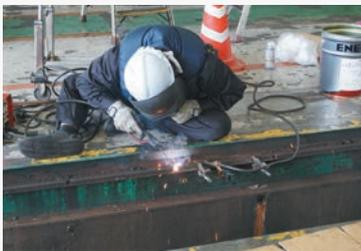
レールを研磨・溶接、がたをその場で修理
