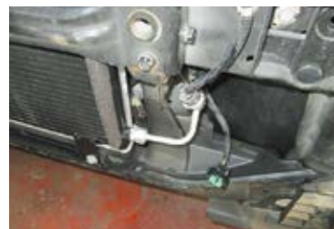
パイプとコンデンサーを交換する
