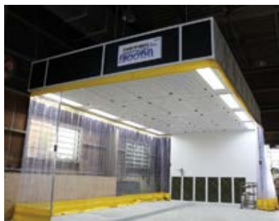
塗装ブースの床面は平岡社長自らコンクリートで ならして整えた
