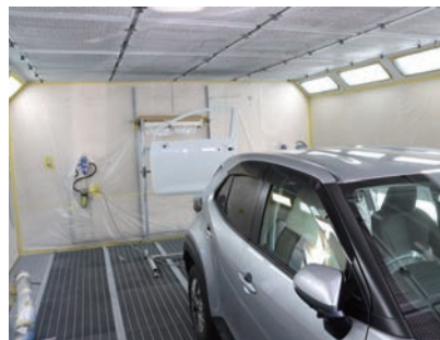
塗装ブース内にはエアフィルターを増設
