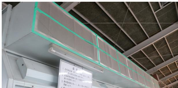
給気1次フィルターの上にフィルターシートを貼り付け、集塵効果をさらに高める方法もある
