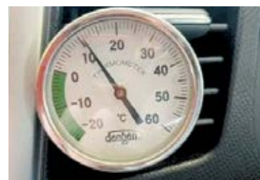
吹出口温度10.5℃を確認
