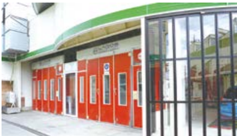
塗装ブースは2基設備する他、3Dのボデー計測装置や4輪アライメントテスターも完備
