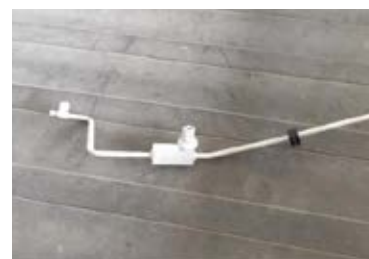
ガスを抜きパイプを外して鉄粉をチェック
